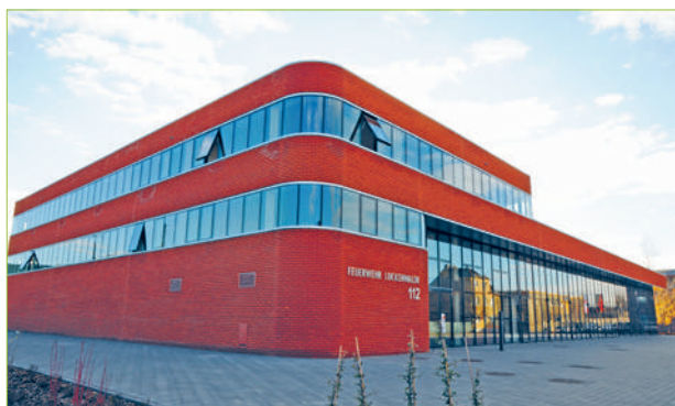
Die PV-Anlage auf dem Dach der Neuen Feuerwache deckt etwa die Hälfte des Strombedarfs ab. Auch ein Speicher soll im nächsten Schritt hinzukommen.
